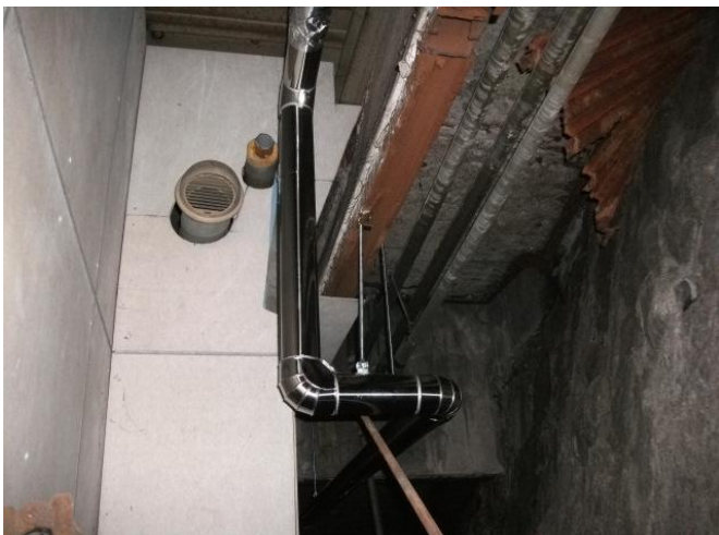
保温~1 板金仕上げ
