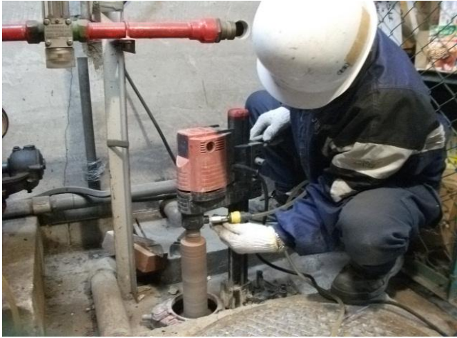
ダイヤモンドコア穿孔工事
