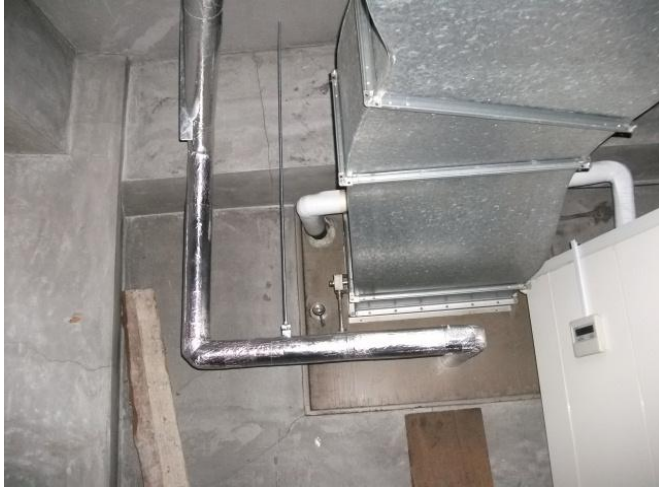
保温～5 屋内GW筒 テープ仕上げ
