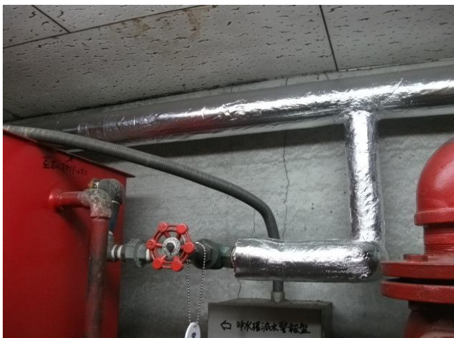
保温～7 受水槽室
