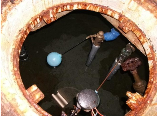
地下受水槽内 ボールタップ新設40A
