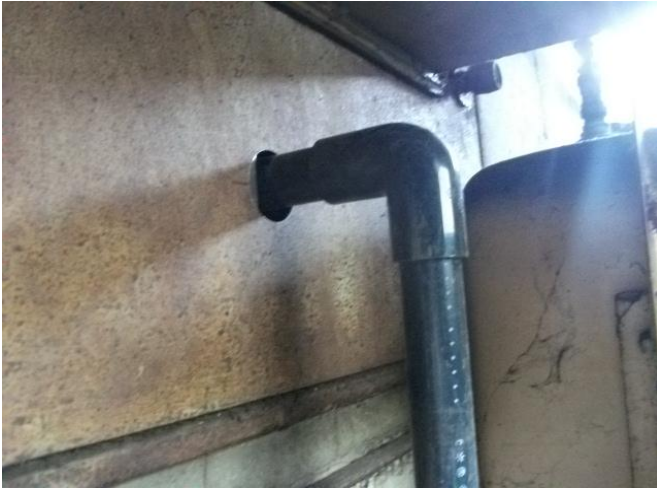
配管~3 室内へ貫通箇所
