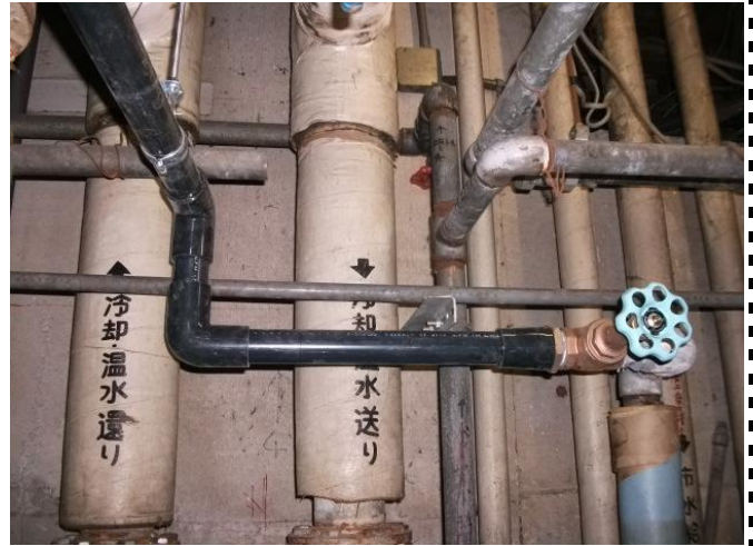
配管~10 既設給水管へバイパス弁取り付け
