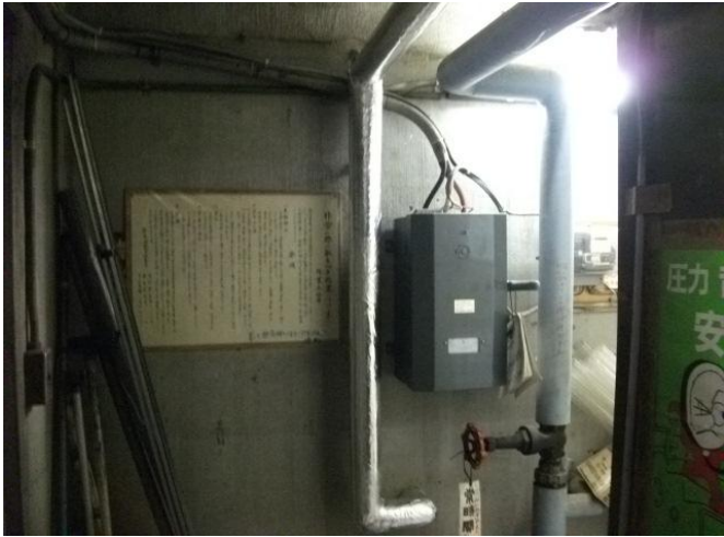
保温～9 機械室内
