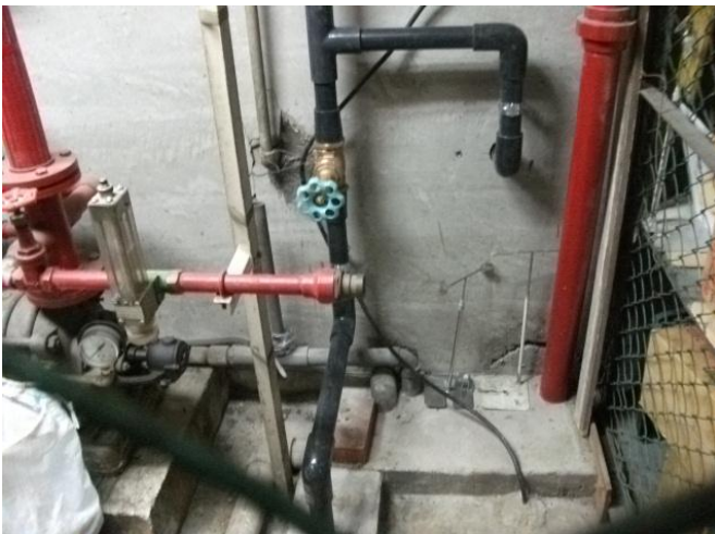
配管~7 地下水槽へ元バルブ取り付け
