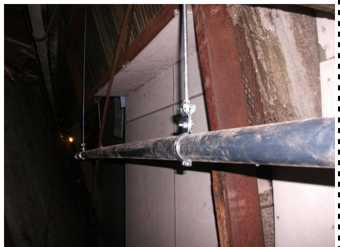
吊りバンド支持金物取り付け
