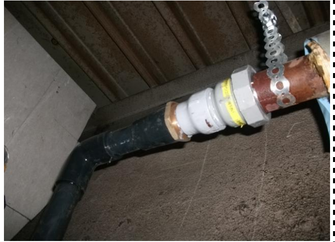
既設管と新設管接続箇所
