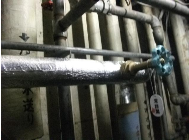
バイパス弁周り
