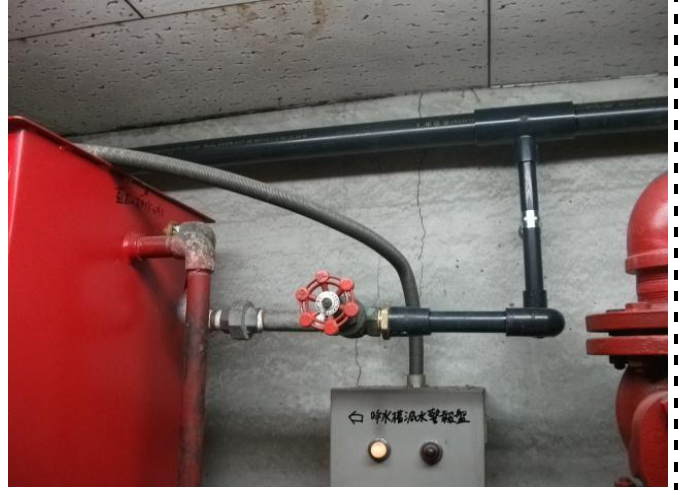
配管~6 受水槽室消化ポンプ呼水槽へ切換箇所
