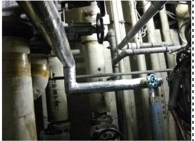
保温～10 機械室内
