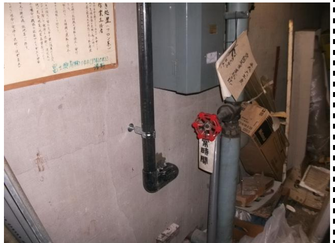
配管~8 機械室へ貫通箇所
